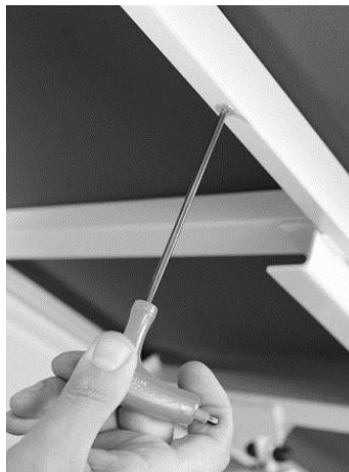
Figura 2: Svuotamento della superficie di appoggio
